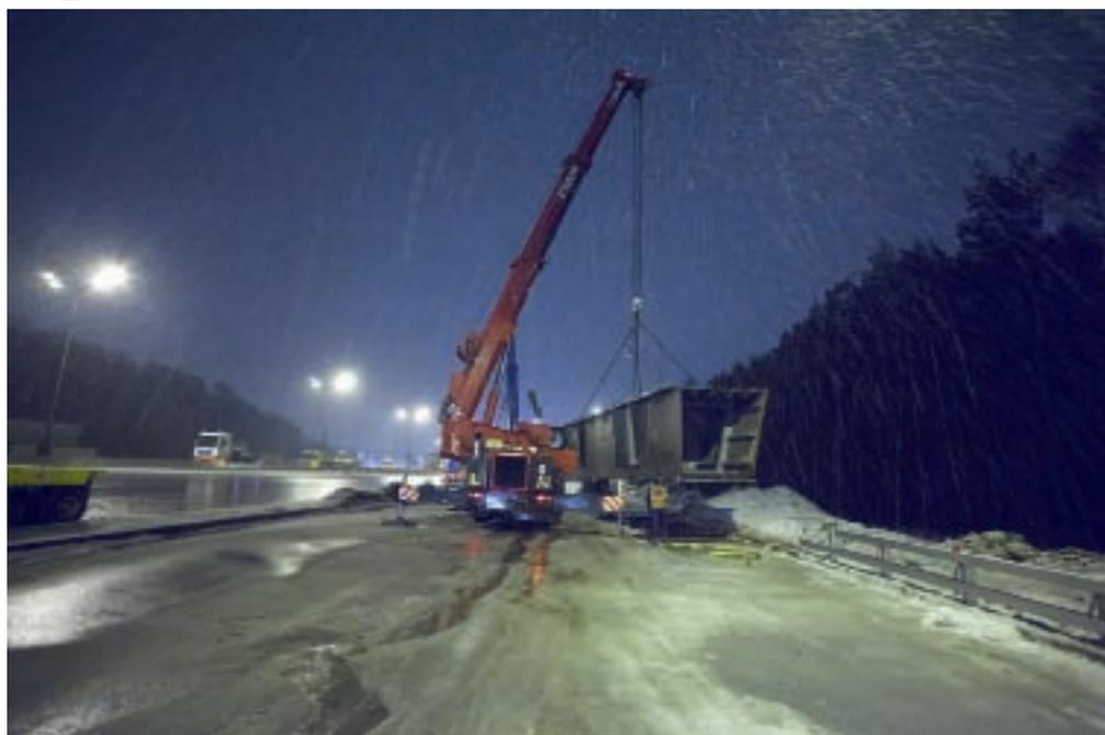
Данная транспортировка груза интересна тем, что для перевозки тяжеловесных негабаритных железобетонных конструкций компания решила использовать самоходные модули Scheuerle. Весогабаритные характеристики балок пролетного строения: длина 41 метр, ширина 3,7 метра, вес 94 тонны.
