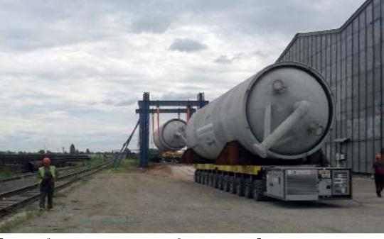
дальнейшем данная портальная система была мобилизована от зоны №1 в зону Цеха №3 (досборки реакторов) и вновь установлена на площадке для такелажа реакторов. Команда такелажников ООО «СВ Транс» проявила профессиональное стерство при проведении работ по выгрузке тяжеловесного негабаритного оборудования с установкой реакторов на тумбы на площадке хранения. На
